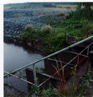
Oravilähden pumppuamo pitää kuivatun suoalueen rantapellot maanviljelykelpoisena ja poltiveden pinnan hallitulla tasolla.
